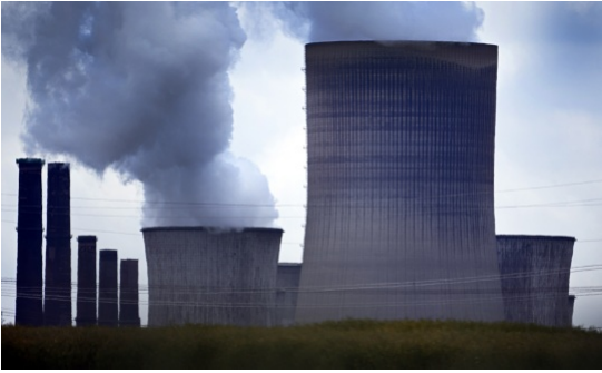
Dampf strömt aus den Kühltürmen des Braunkohlkraftwerks Niederaußem. [FEDERICO GAMBARINI/PICTURE ALLIANCE VIA GETTY IMAGES]
